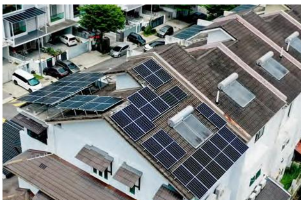
Kampung Baru Balakong, Selangor 18.4kWp
